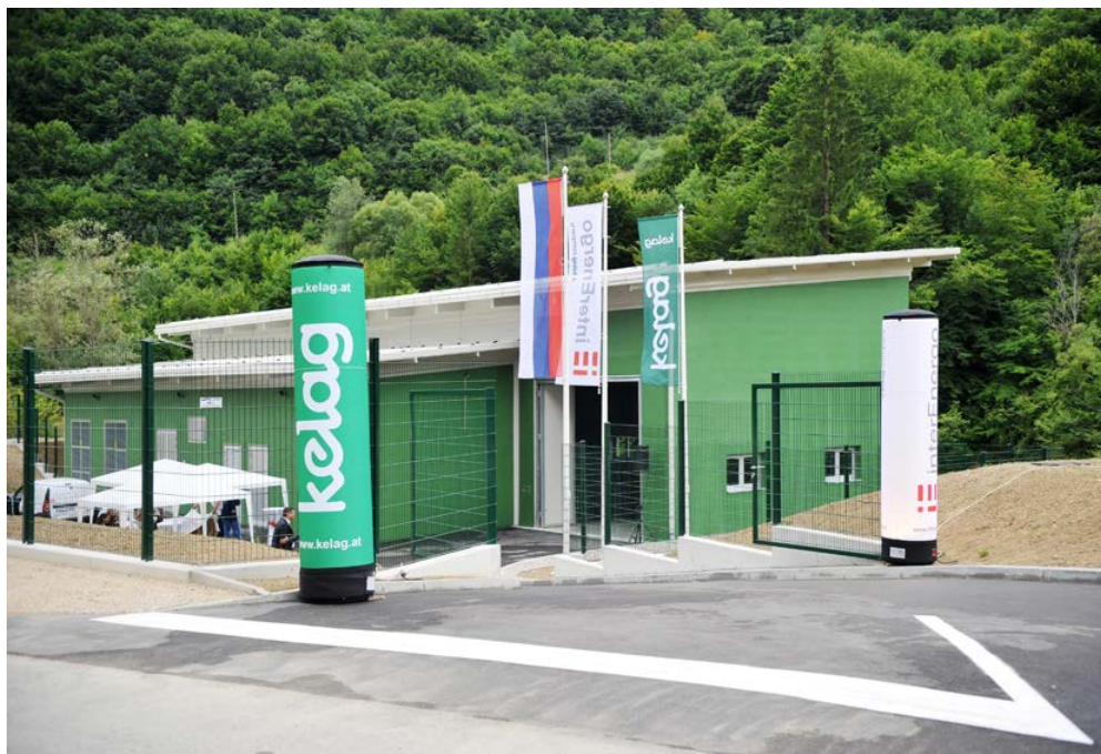
Zunanost male hidroelektrarne Zapeče
