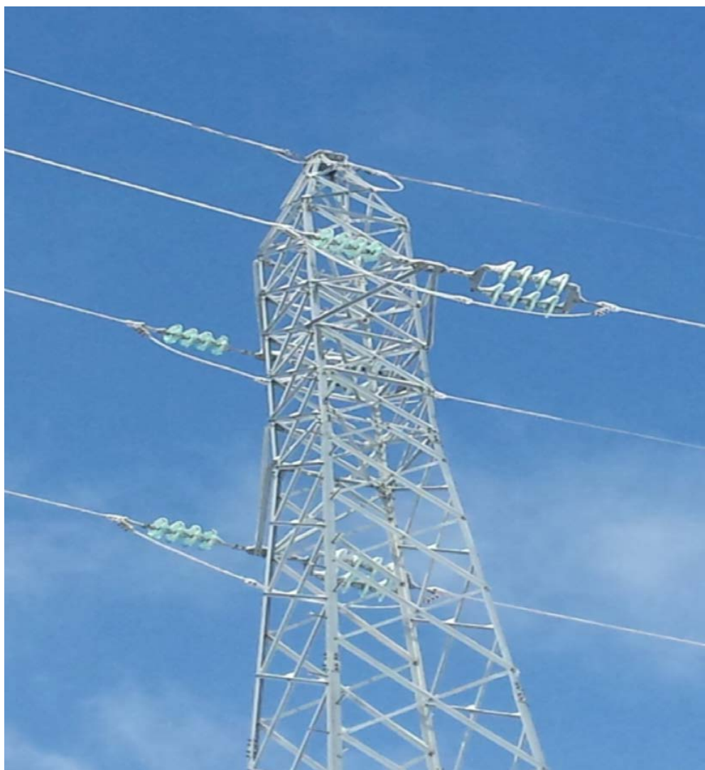
Nov daljnovod, ki služi za distribucijo proizvedene el. energije iz mHE Zapeče in mHE Novakoviči
